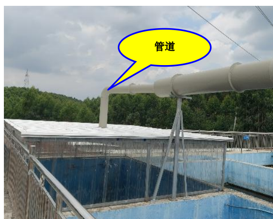
污泥浓缩池加盖
