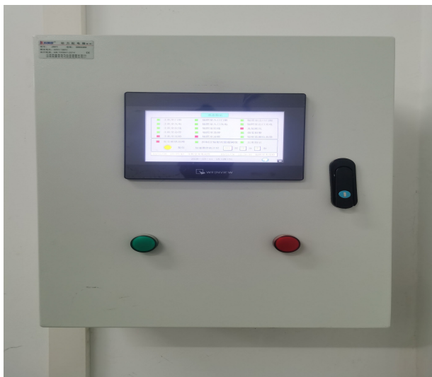
安全联锁系统控制电箱
